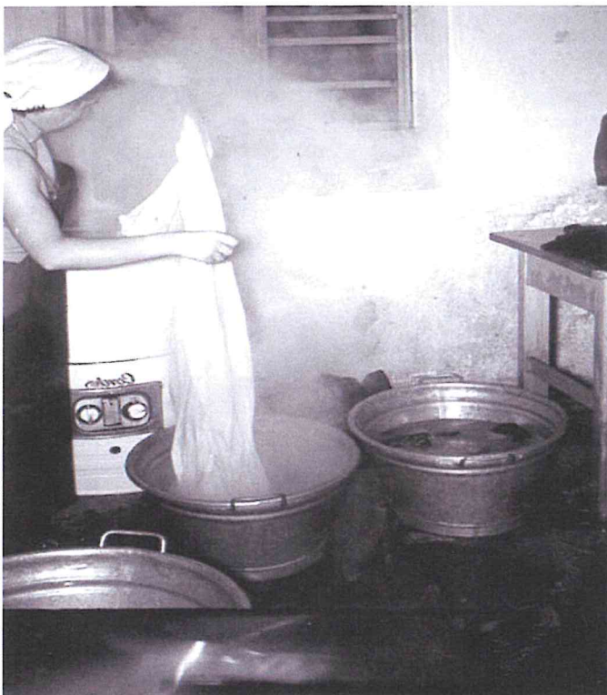
und die ebenso moderne Waschküche
